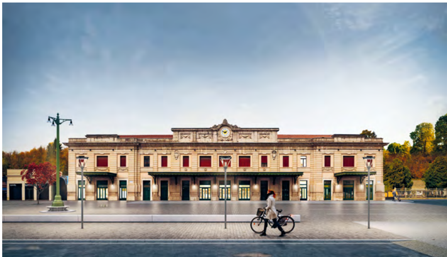
Concorso piazza Stazione di Belluno / 2017 / n. 35 partecipanti Vincitori: Colombo/Molteni Iarchs architettura (Emanuele Colombo, Paolo Molteni, con Alessandro Gaffuri giovane professionista e Maurizia Molteni sicurezza); appalto lavori aggiudicato
