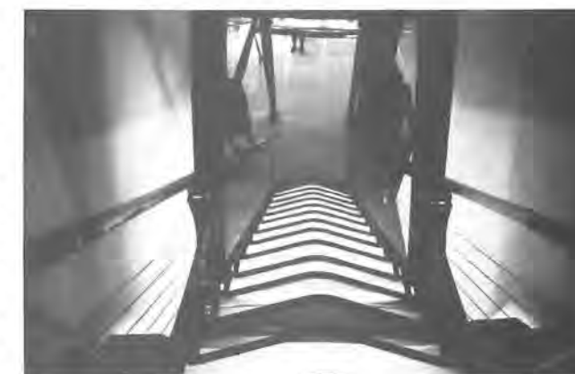
Stahlkonstruktion mit integriertem Treppenaufgang
