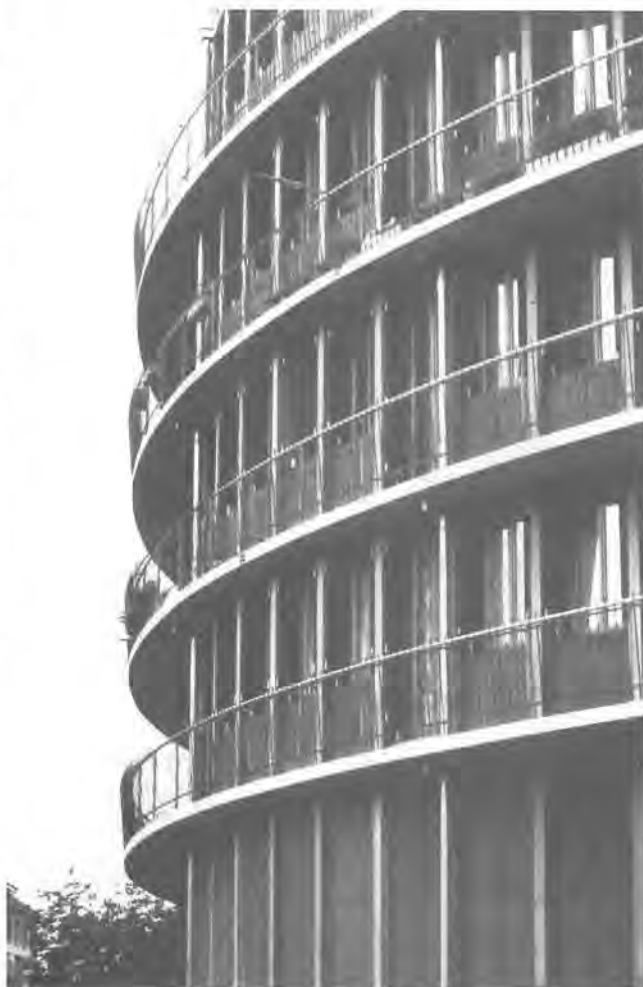
Ansicht der Straßenseite
