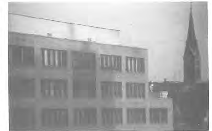
Ansicht der Straßenseite
